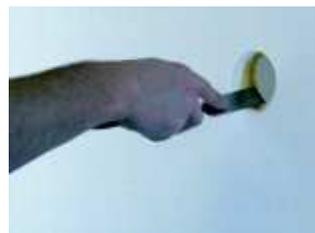
Applicare della MTH COLLA PU sulla superficie circolare interna del cilindro di montaggio MTH CILINDRO
