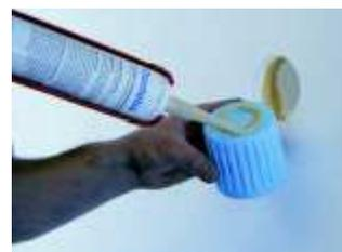
Premere il cilindro di montaggio MTH CILINDRO a filo dei pannelli isolanti nella sezione fresata. Il colore blu consente un facile controllo della posa di tutti i cilindri di montaggio MTH CILINDRO.
